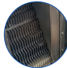
1 Jeux de lames fixes et mobiles montés sur traverses
